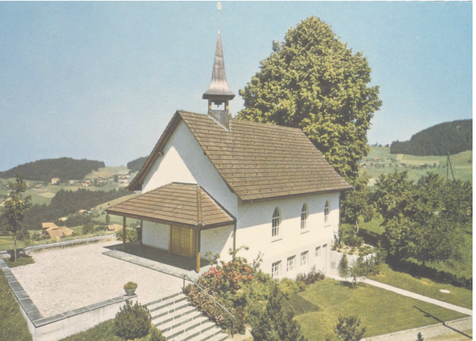
Kapelle nach dem Umbau 1960
